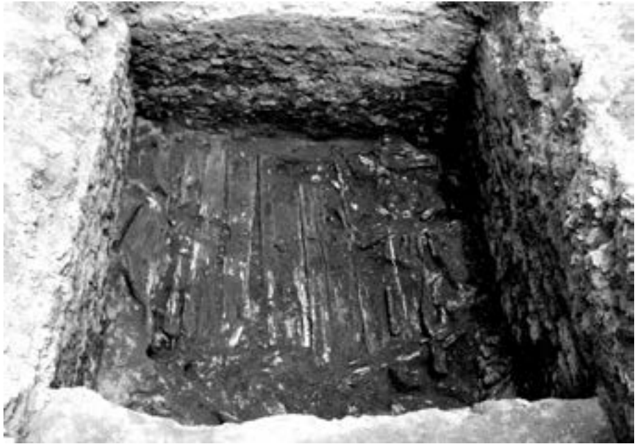
4. kép. A második pince beszakadt födéme
